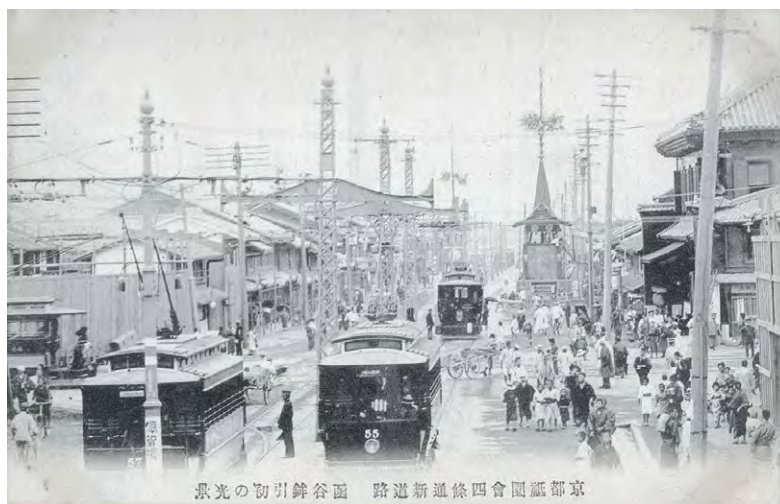
写真2 京都祇園会四条通新道路 函谷鉾引初の光景
